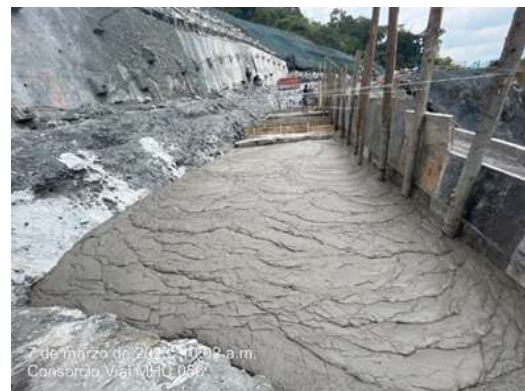
Figura 19. Estado del tramo en falla del proyecto Transversal Cusiana en el proceso de instalación del concreto celular.
