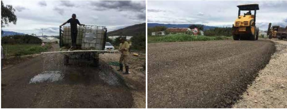
Figura 9. Humectación y compactación del material de fresado.
