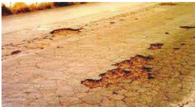
FIGURA 5. DESGASTE DE LA SUPERFICIE DE LA VÍA
