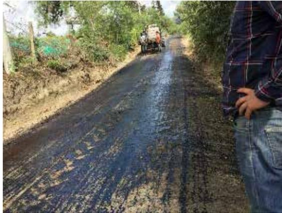
Figura 11. Imprimación con emulsión asfáltica para sellado.
