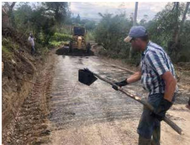
Figura 10. Imprimación con emulsión asfáltica entre capas
