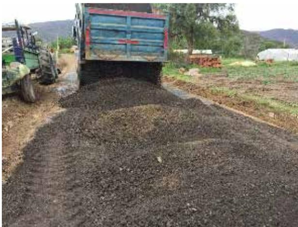
Figura 8. Extendida material de fresado.
